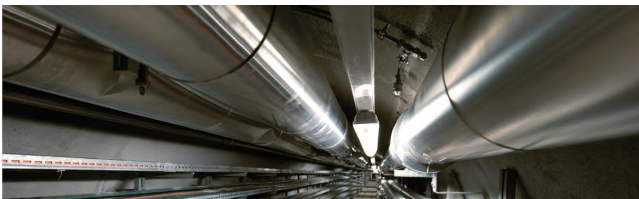
Beim Ausgang Europaallee in der Passage Sihlquai im westlichen unterirdischen Teil des Hauptbahnhofs Zürich befindet sich «hinter den Kulissen» ein unterirdischer Werkbereich. Von dort ausgehend verläuft zudem ein mehrere hundert Meter langes Kabelkanal-System. Dieses besteht aus einem Längskanal, der sich bis zur Unterführung Langstrasse erstreckt. Quer dazu befinden sich sieben Querkanäle, die vom Hauptkanal aus unterirdisch die Gleisanlagen durchqueren.
